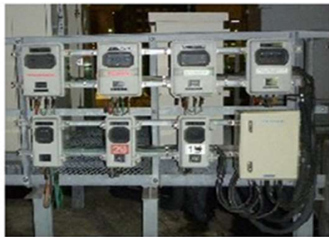
設置された各種検知器とDL-U2盤
